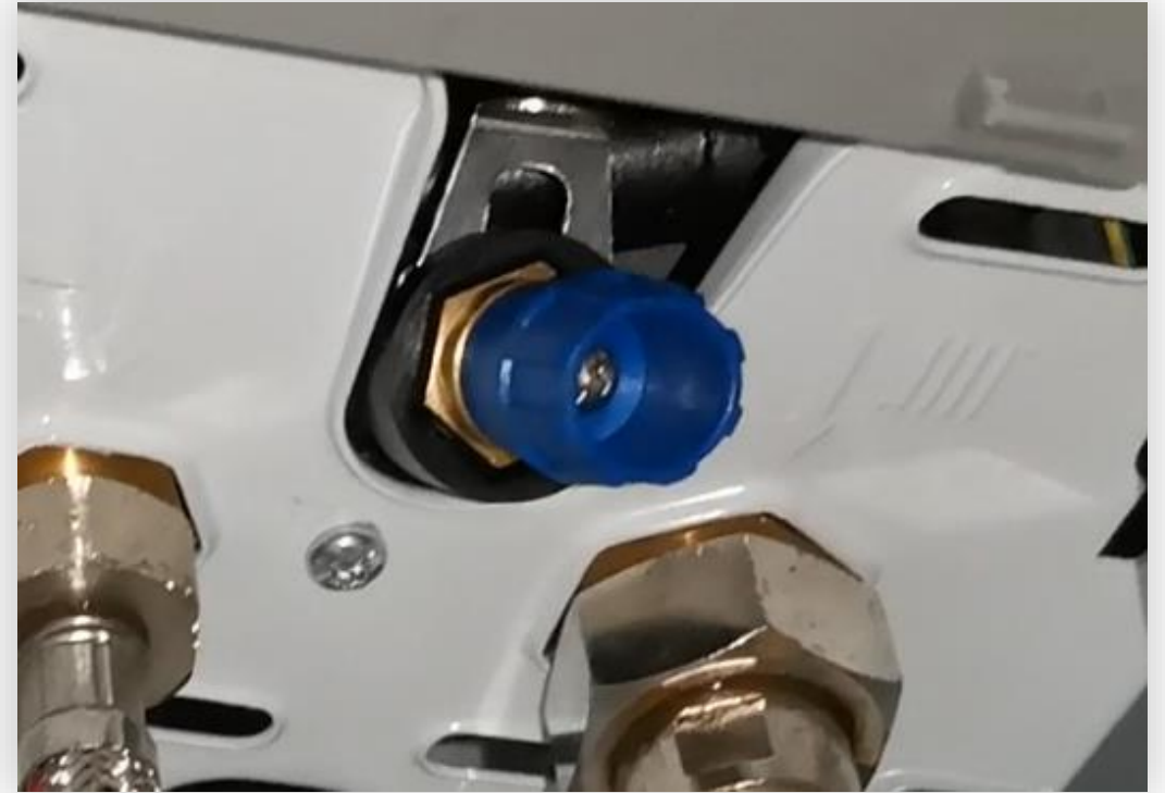
Кран подпитки синего цвета находится на нижней панели
