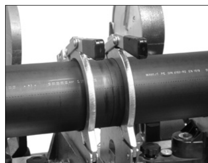
Трубы, правильно подготовленные к сварке
